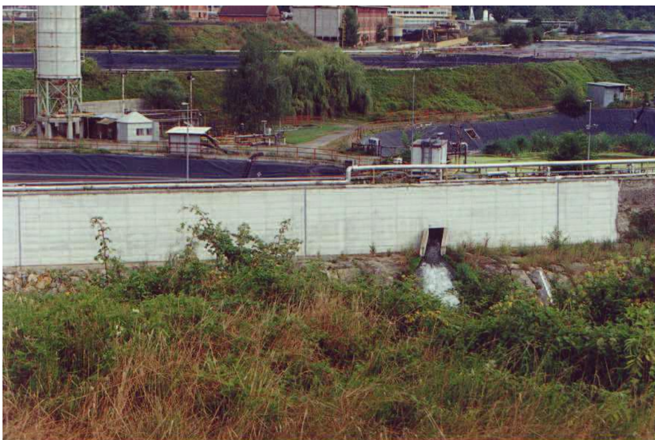
Foto 15 – Contenimento percolato Acna Cengio
