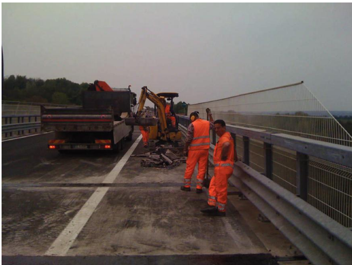
Foto 41 – Riqualifica barriere Viadotto Morey
