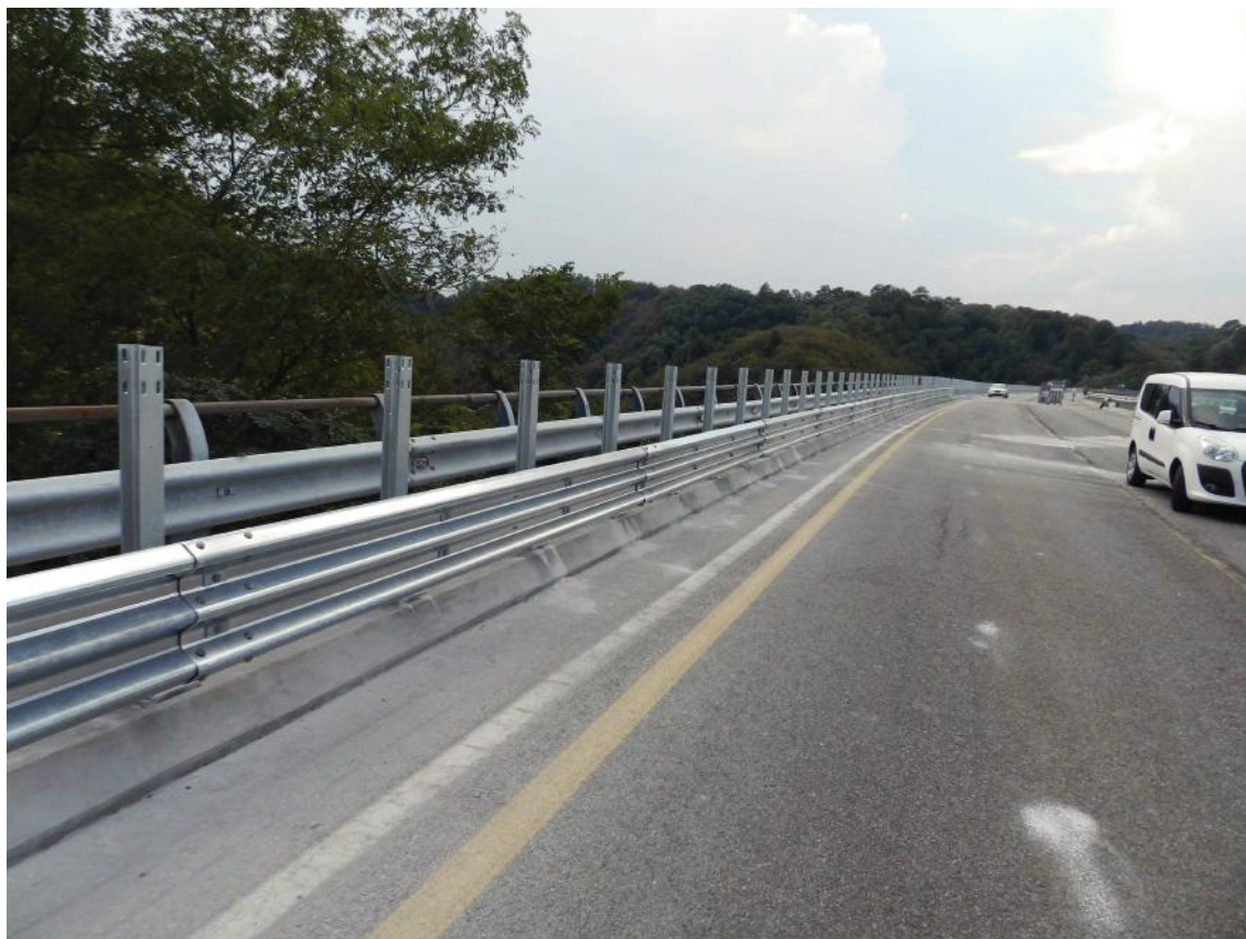
Foto 42 – Nuova barriera Viadotto Rastello
