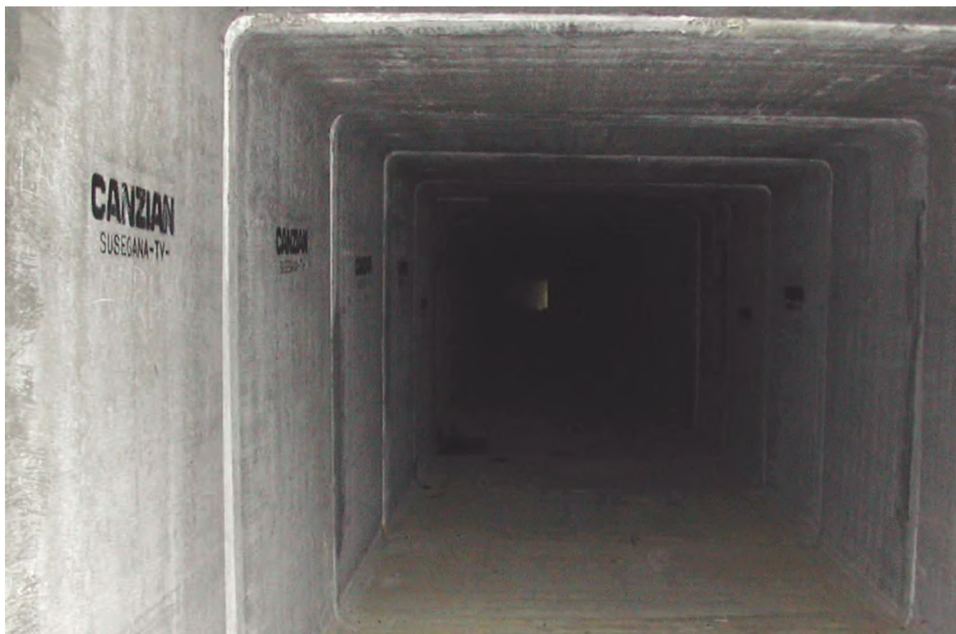
Foto 19 - Costruzione canale scolmatore (dim. 4.50*3.00 mt)
