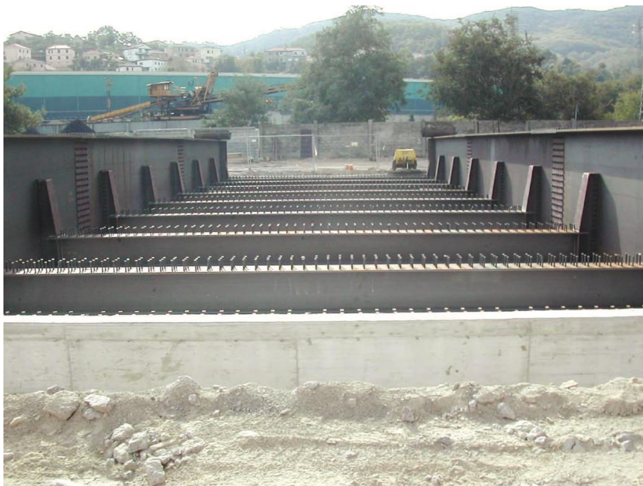
Foto 36 –Ponte sul Torrente Segno a Vado Ligure
