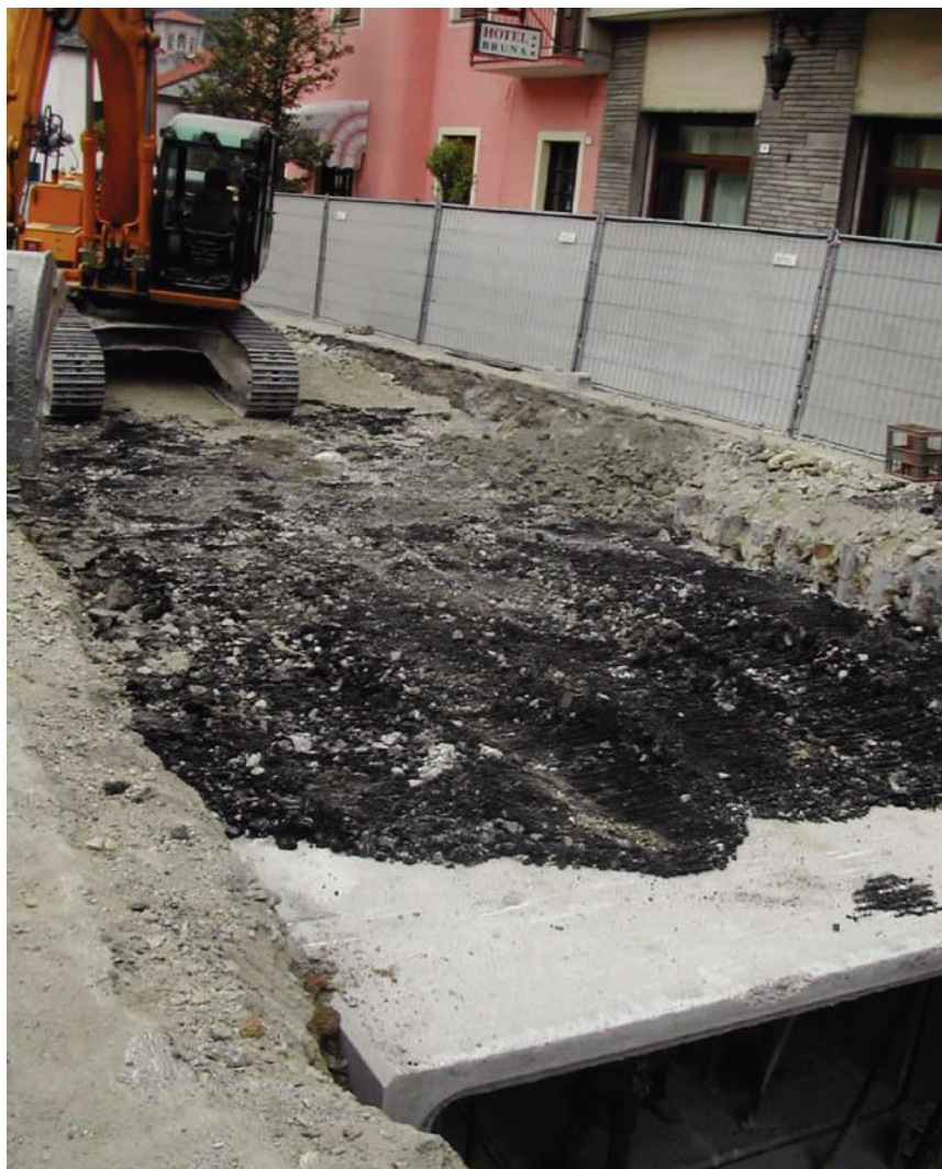
Foto 18 – Costruzione canale scolmatore (dim. 4.50*3.00 mt)
