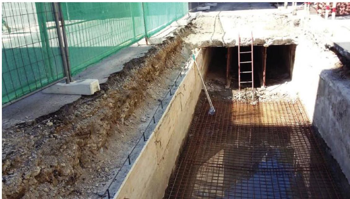
Foto 43 – Ripristino canale Via S. Lorenzo - Savona
