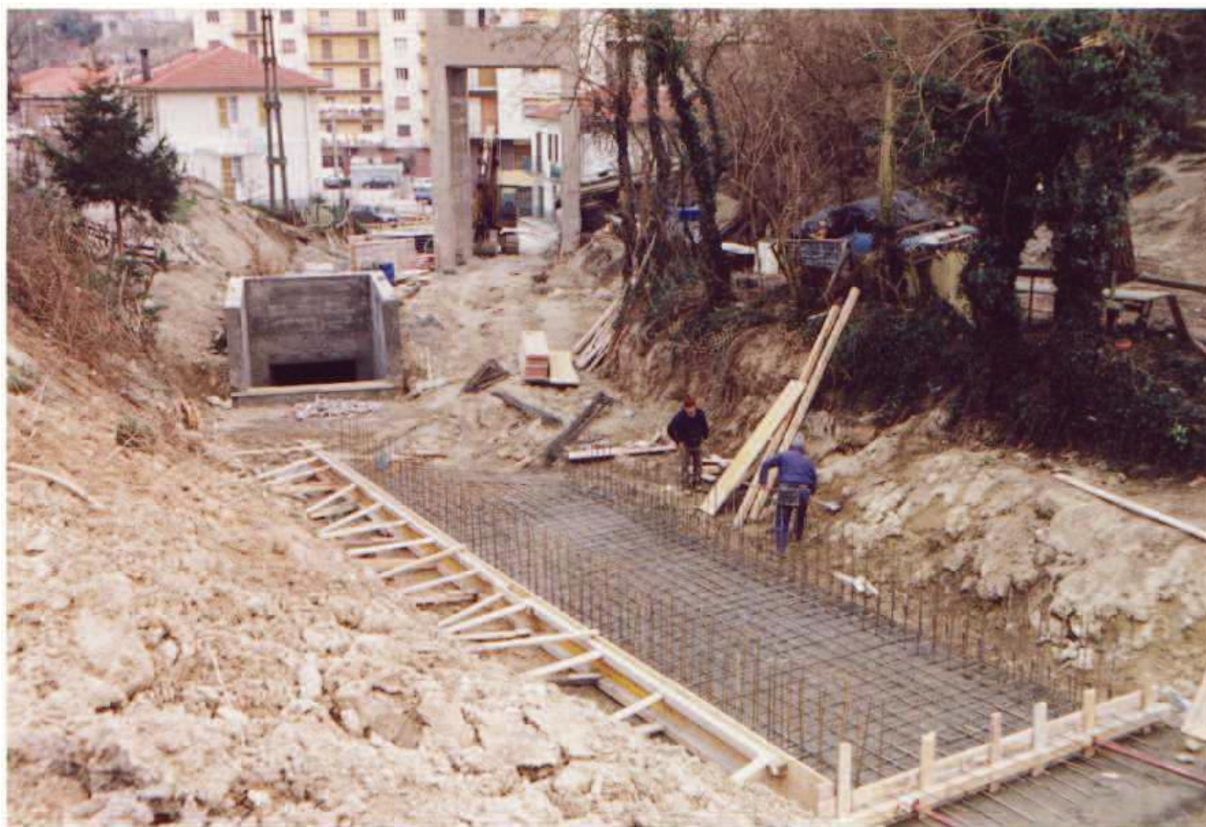
Foto 1 – rifacimento Rio Palazzina – Altare
