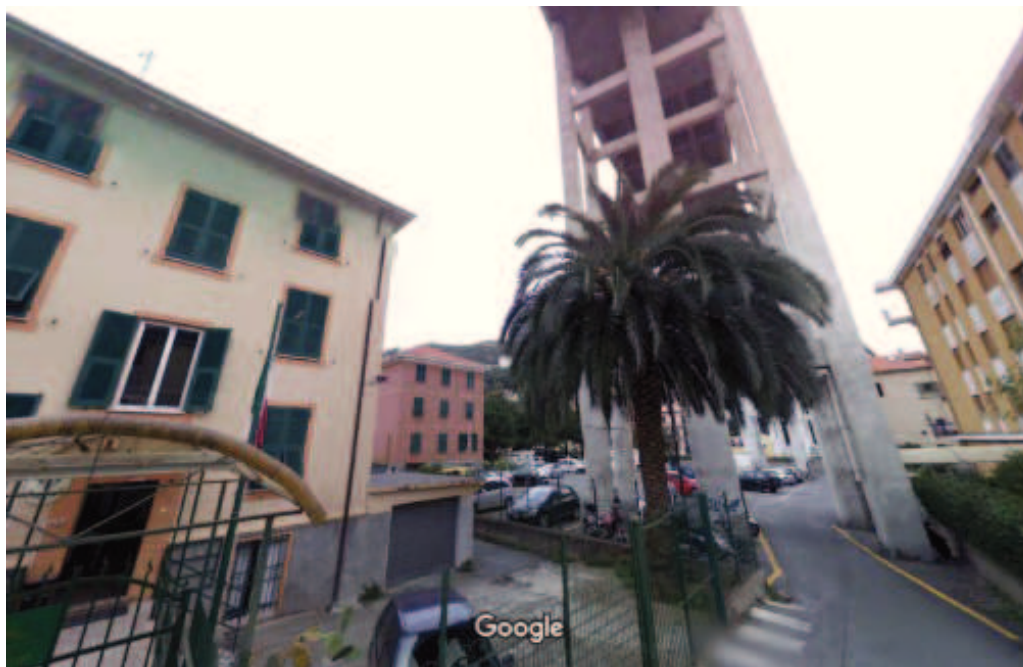
Sulla sinistra l'immobile in oggetto, al centro i pilastri del viadotto
