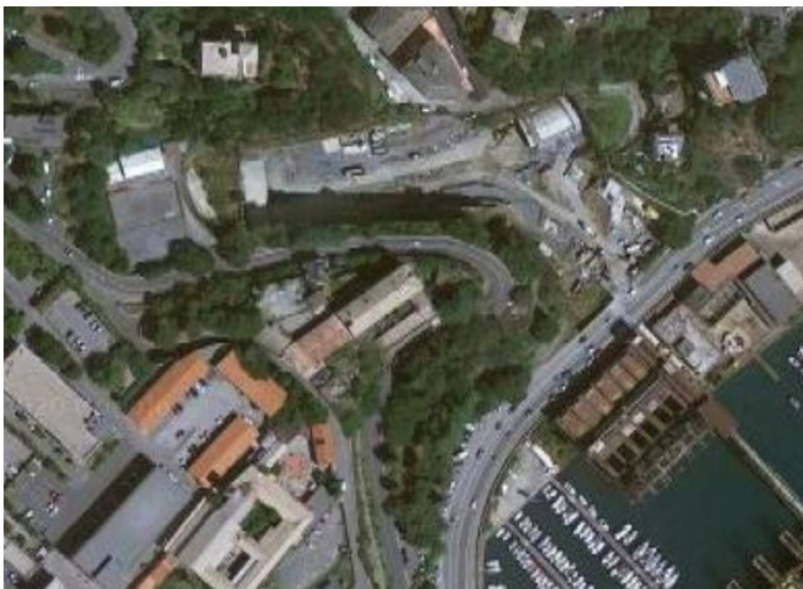
Vista aerea – al centro il cespite immobiliare, in alto il cantiere dell'Aurelia bis, a dx la stazione di Miramare, a sx il complesso dell'ex convento di San Giacomo e la caserma della G.d.F.
