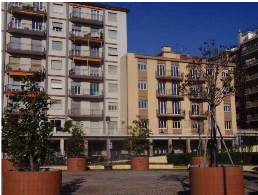
FOTO 2 – VISTA ESTERNA , FACCIATA SU VIA TRILUSSA
