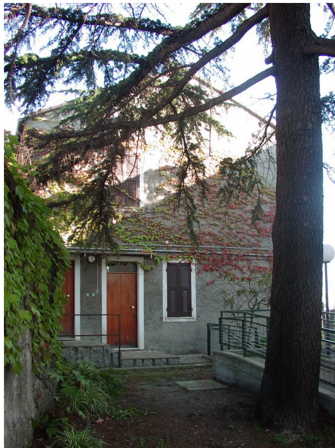
Prospetto sud – ingresso al pianterreno ed al primo piano
