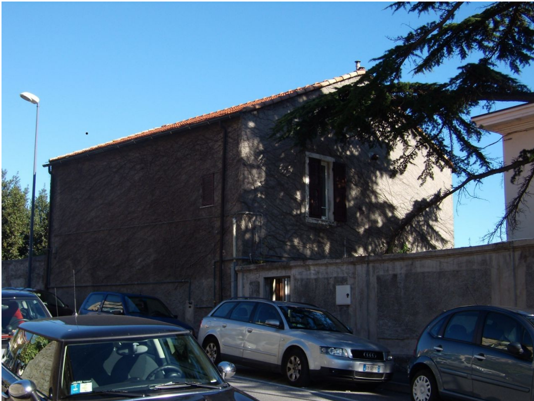
Prospetto Ovest su via Amendola
