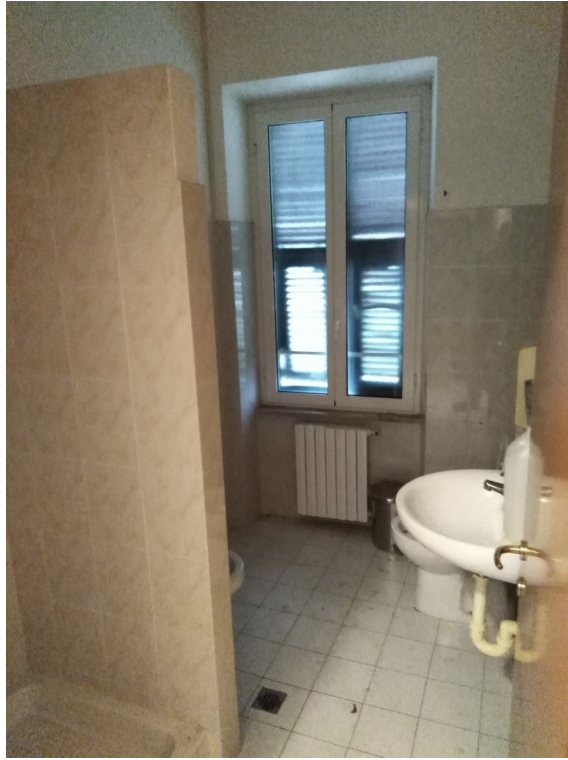
Interni, bagno primo piano
