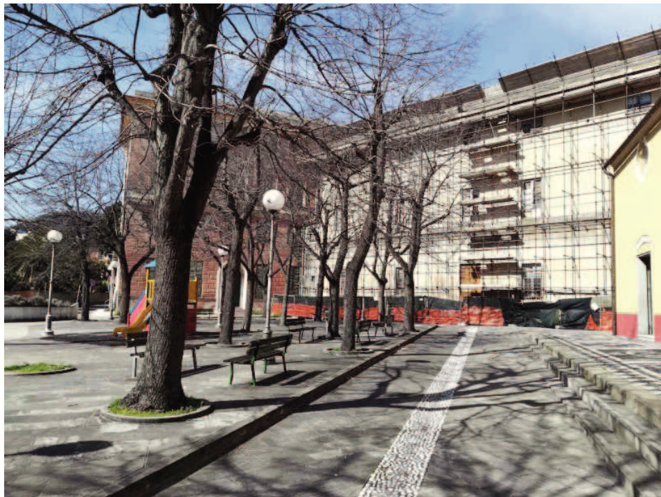
FOTO 1 – VISTA ESTERNA LATO PIAZZA
