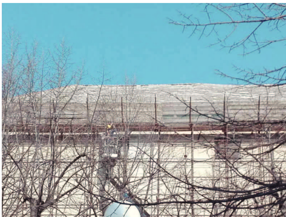
FOTO 2 – VISTA ESTERNA , PARTICOLARE FALDA COPERTURA SU PIAZZA
