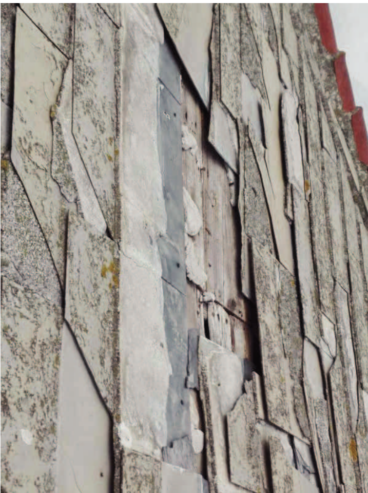
FOTO 5 – PARTICOLARE COPERTURA FALDA LATO PIAZZA
