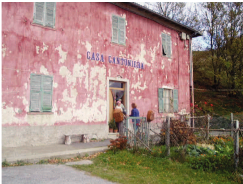
FOTO 1 – FACCIATA SU STRADA PROVINCIALE ED INGRESSO
