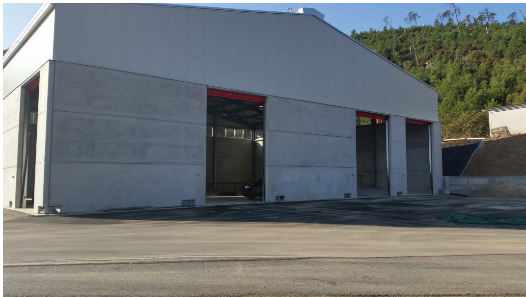
Fig. 5 Capannone per trattamento e ricovero RSU
