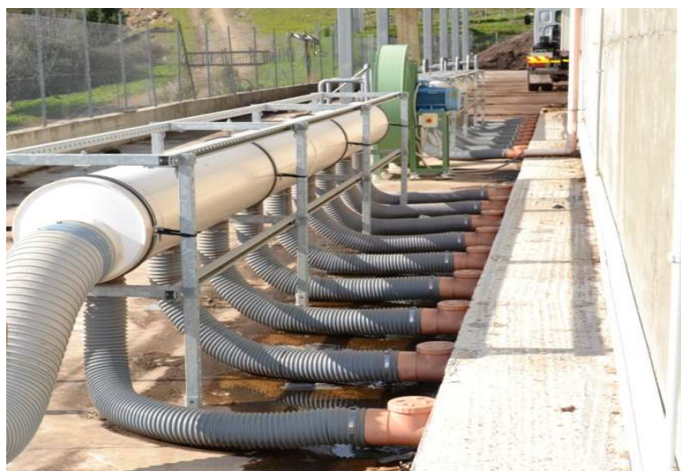
Fig. 12 Gruppo di ventilazione
