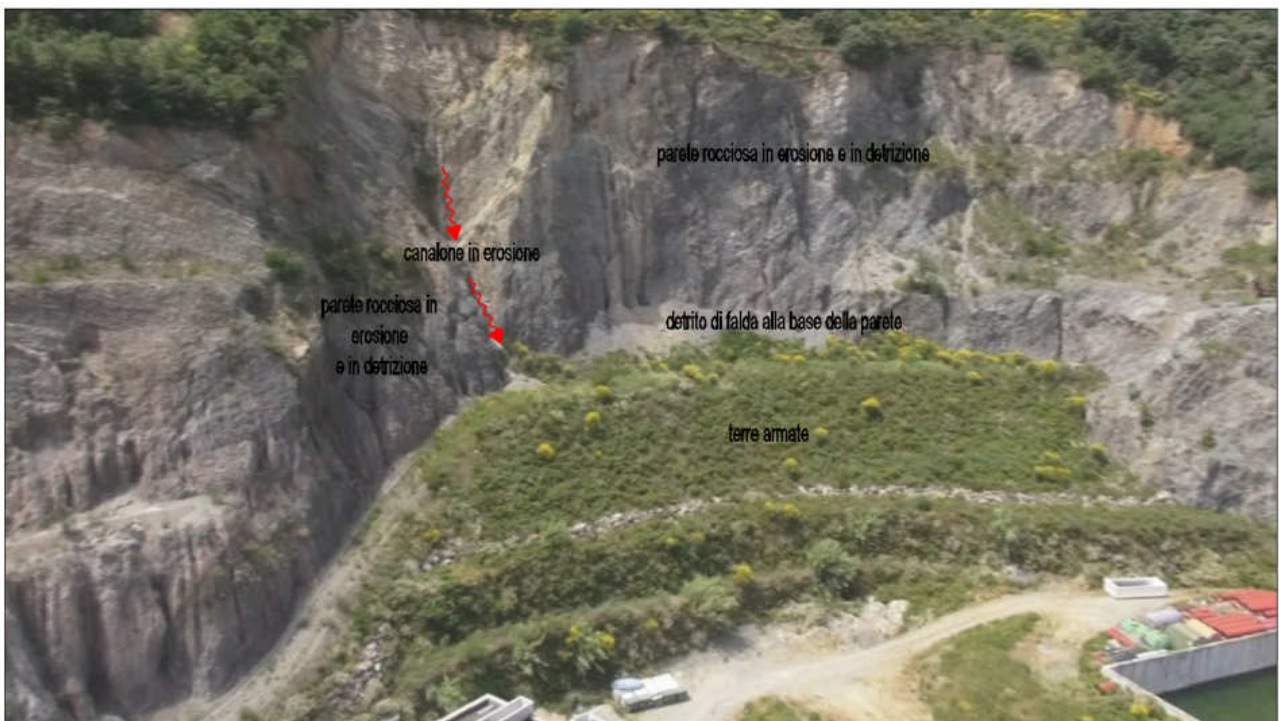
Figura 6.4 - Criticità della parete rocciosa del settore Sud-Ovest
