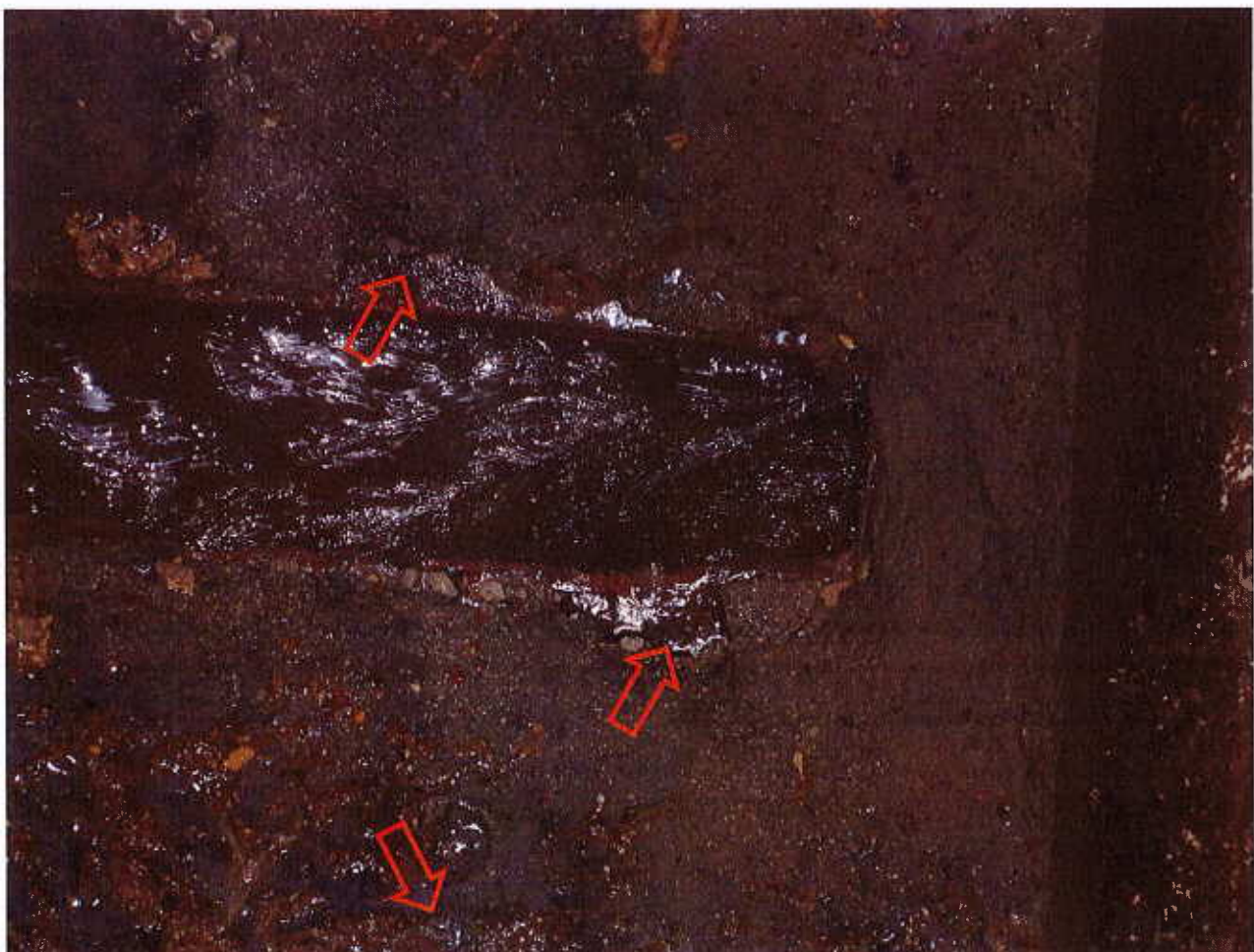
Interno pozzetto di ispezione lungo linea fognatura nera
