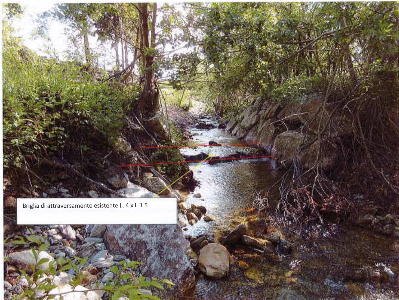
Briglia e difesa spondale attraversamento (A8) Rio Gaviano a monte località Bosco
