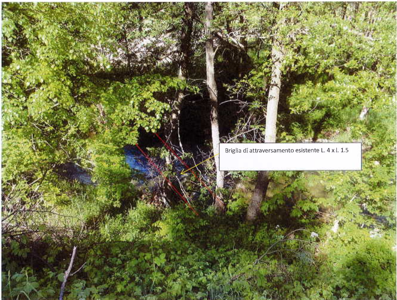
Briglia attraversamento (A7) Rio Tamburlin a monte località Bosco
