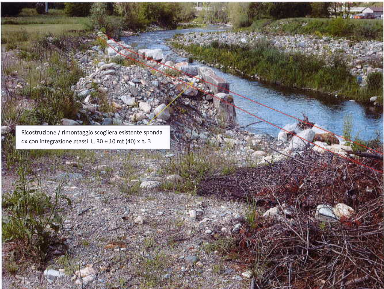
Difesa spondale a monte attraversamento (A3) Fiume Bormida in località Giaire – Stagnacci
