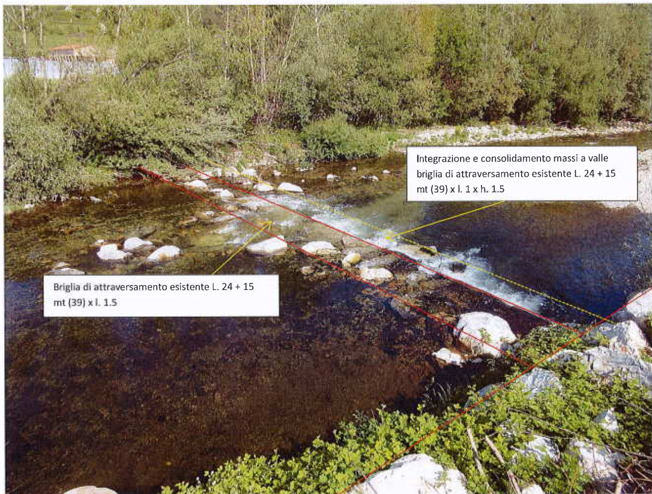
Briglia e difesa spondale attraversamento (A3) Fiume Bormida in località Giaire – Stagnacci
