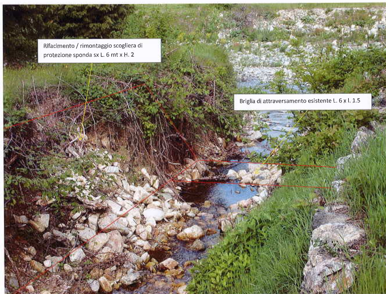
Briglia e difesa spondale attraversamento (A9) Rio della Guardia in località Giaire
