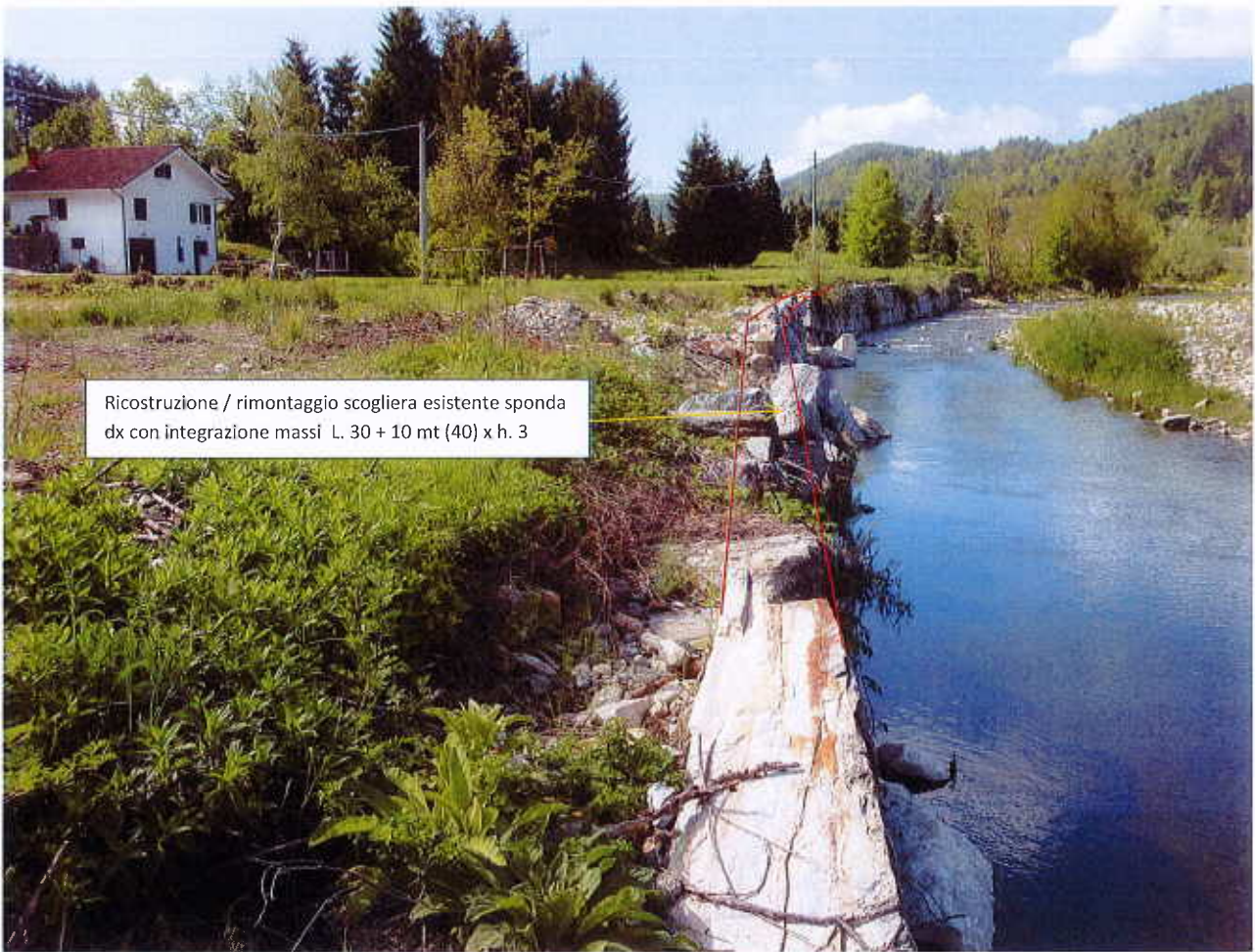
Difesa spondale a monte attraversamento (A3) Fiume Bormida in località Giaire – Stagnacci
