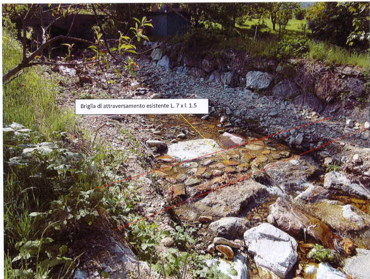
Briglia e difesa spondale attraversamento (A6) Rio Bosco in località Bosco
