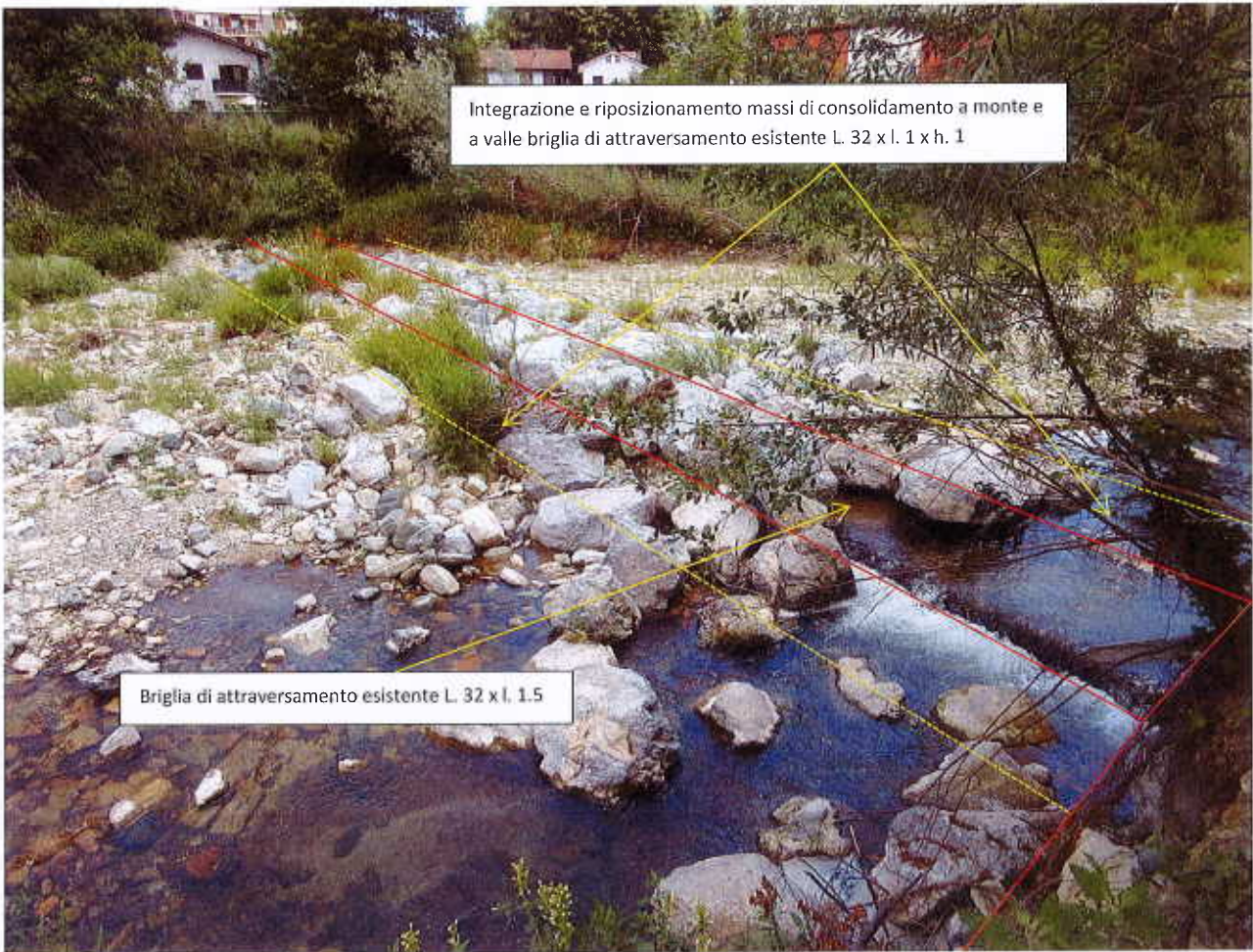
Briglia e difesa spondale attraversamento (A5) Fiume Bormida in località Capoluogo
