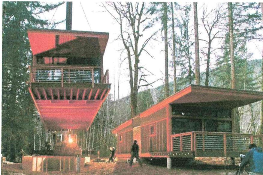
Esempio di fase di consegna e assemblaggio di struttura prefabbricata modulare avanzata, già finita in ogni sua componente.
