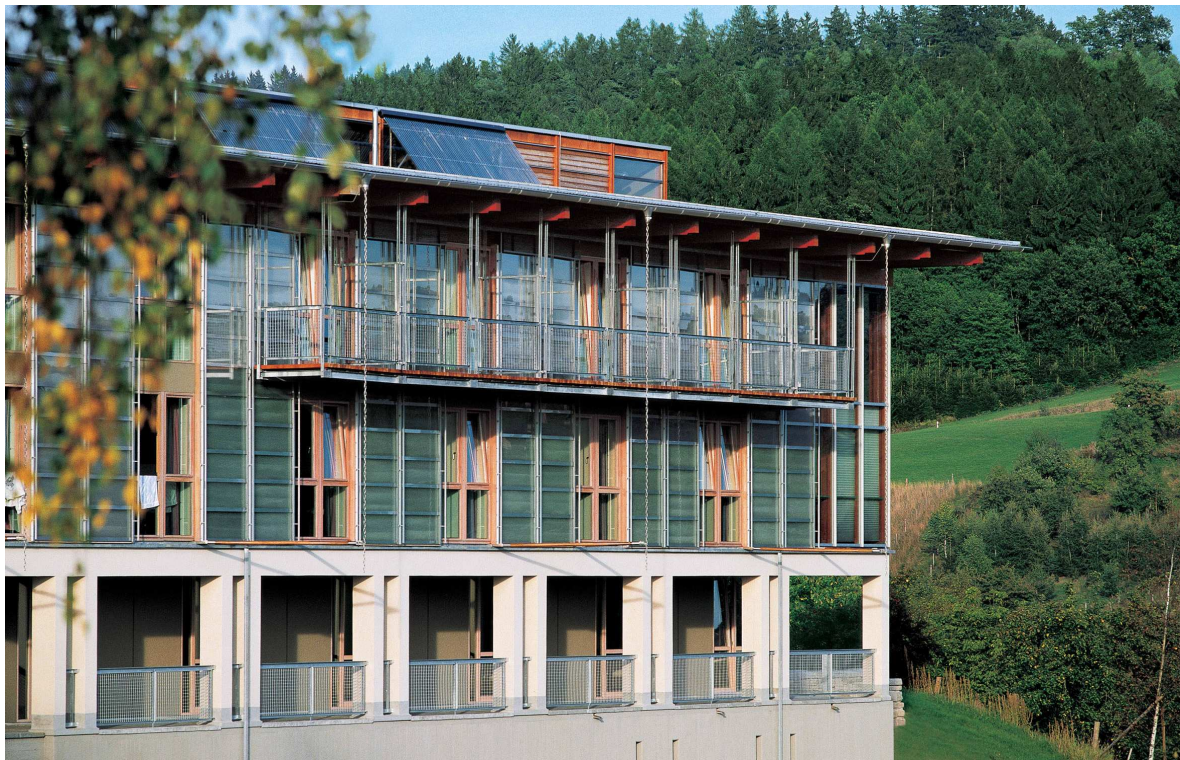
01. Thomas Herzog, Ostello a Windberg, Germania, 1991 (foto di Peter Bonfig fornita dallo studio di Thomas Herzog); l'edificio ospita in facciata e in copertura sistemi solari passivi e attivi, le parti fisse dell'involucro a sud ospitano sistemi di isolante traslucido (TIM).
