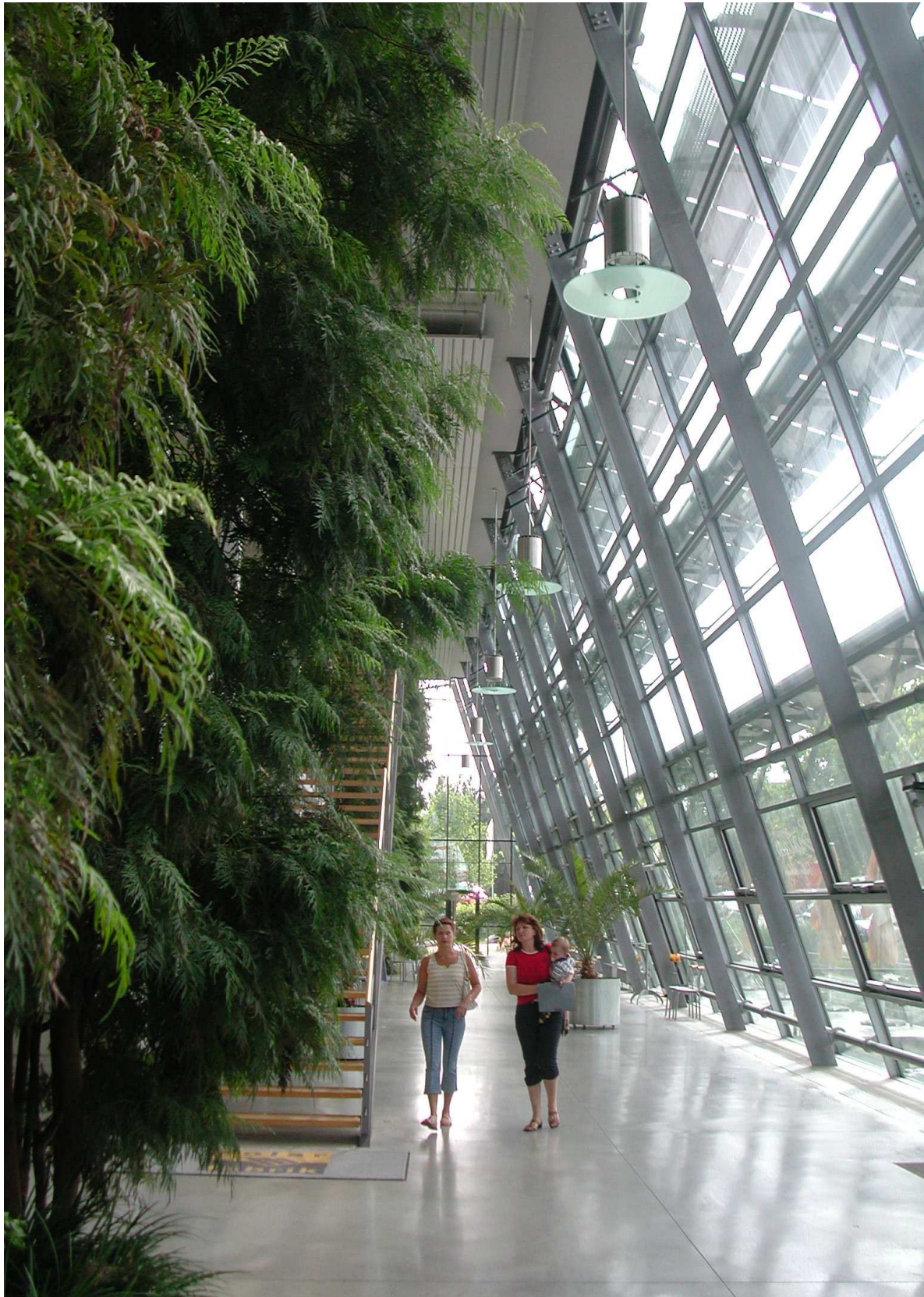
16. Fred Rolf, Matthias Hotz, Fabbrica per la produzione di celle solari, Friburgo, Germania, 1998; l'edificio presenta sul fronte sud un ampio padiglione vetrato come spazio d'accesso, comunicazione, luogo per eventi. Questo spazio è una serra, con vetrate ad alto isolamento, avente funzioni di climatizzazione invernale (con sistema passivo integrato da un sistema alimentato ad olii vegetali) e di climatizzazione estiva, con bocchette per la ventilazione naturale e solette con ventilazione integrata. La facciata sud ospita 210 metri quadrati di moduli fotovoltaici che, oltre a produrre energia, servono come frangisole per evitare fenomeni di surriscaldamento.
