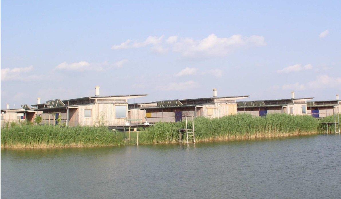
08. Georg Wolfgang Reinberg, Insedimento turistico Inselwelt Jois, Neusiedler See, Austria, 1995-2001; gli edifici sono stati realizzati su quattro isolotti di un bacino portuale artificiale degli anni '70, che, nel tempo, ha assunto caratteristiche di pregio ecosistemico; l'intervento è un esempio di riuscita integrazione del costruito con il contesto naturalistico; gli edifici, realizzati con strutture leggere ed elementi quasi totalmente prefabbricati e montabili a secco (per ridurre l'impatto di cantiere), sono caratterizzati dall'impiego di soluzioni solari attive e passive.
